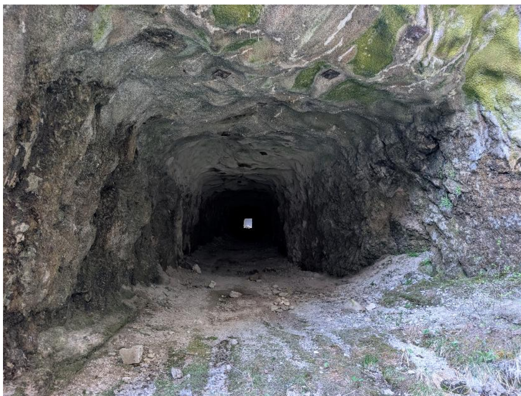
Foto 9: innesto nella galleria esistente
